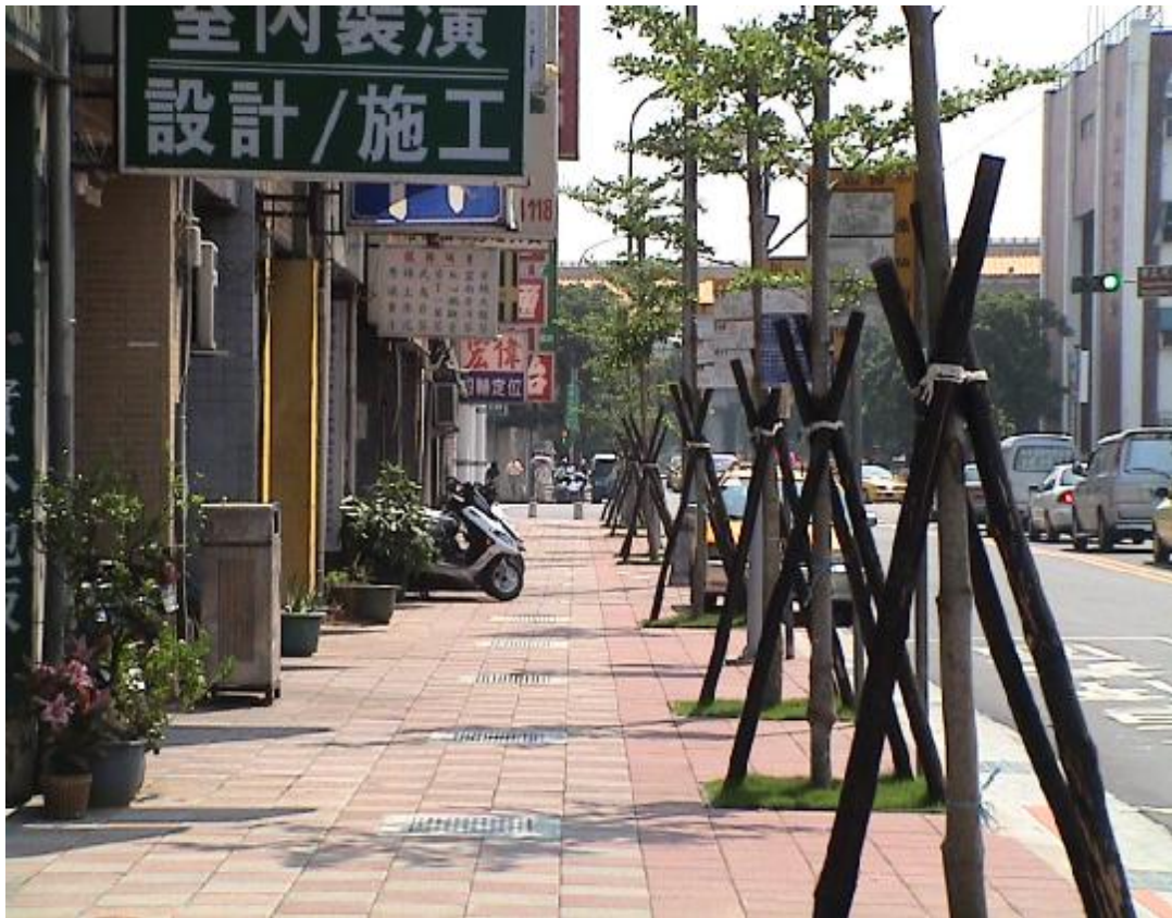
照片 35：94 年 6 月完成儒學大道改善工程
