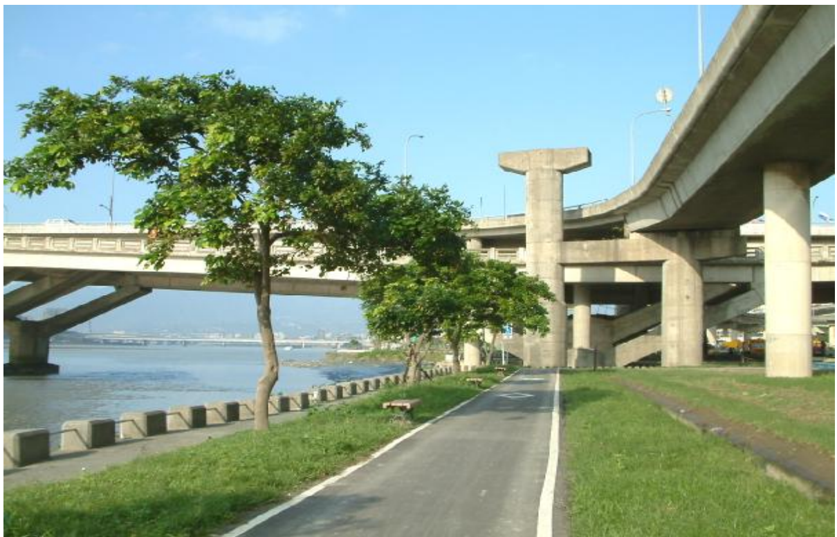
照片 24：淡水河三號水門至光復橋腳踏車道
