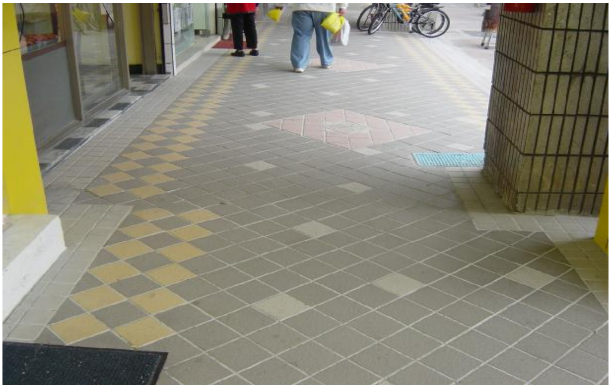
照片 18：和平東路 2 段 20 號改善後
