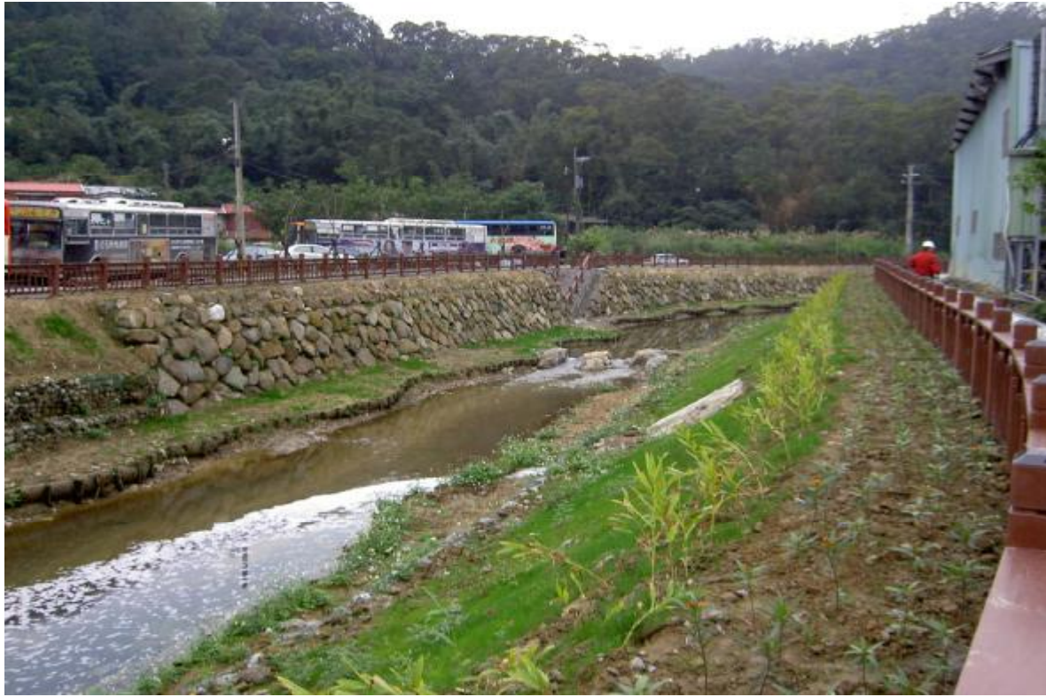
照片 19：內溝溪中游段河道整治工程之生態工法
