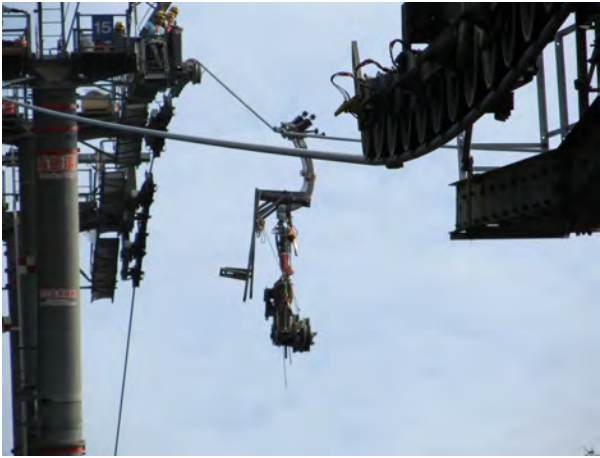
照片 63 貓空纜車年度檢查維護作業－「變形金鋼」運送索輪組
