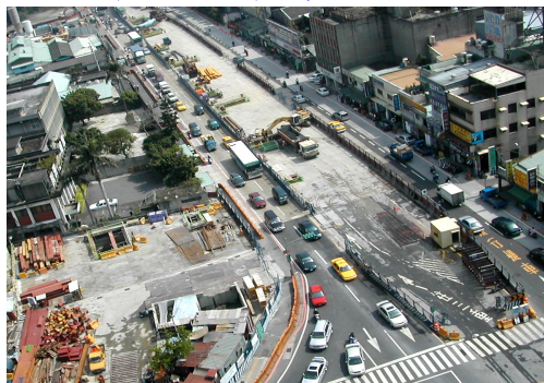
新莊線縣轄段CK570D頭前庄站餘土運棄情形
