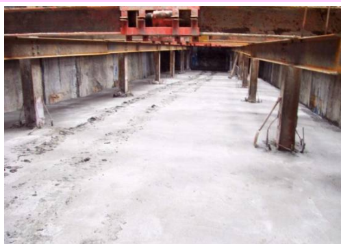
CL700B區段標之CL804標蘆洲站明挖面PC澆置完成
