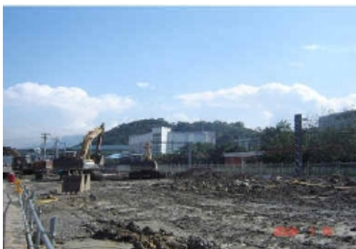
南港線CE730B區段標CE832子施工標淺層開挖施作
