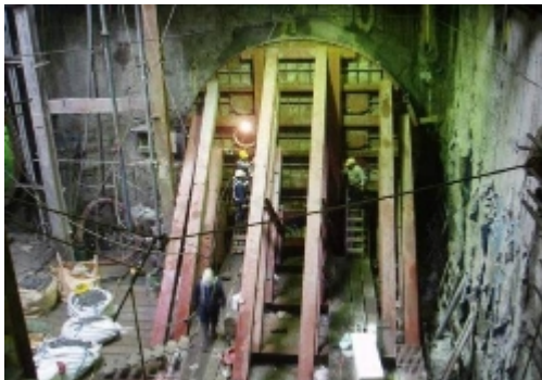
CL700A區段標CL800標三重國小站潛盾到達端背填灌漿作業
