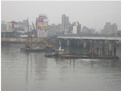
CK570C標道岔段預鑄混凝土塊拋放
