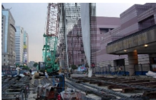
信義線60CM鋼筋籠吊放情形
