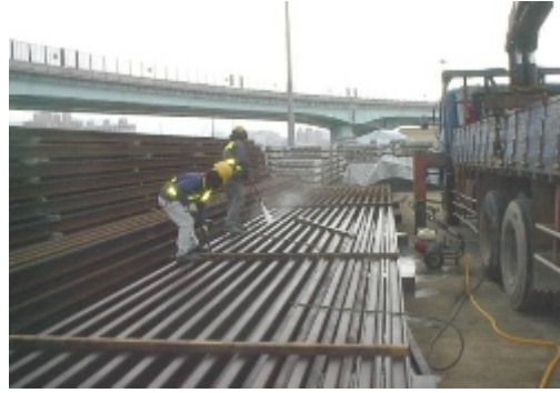
土城線CD550區段標之CD511標於土城機廠辦理鋼軌備品清理
