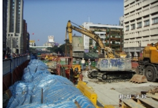
新莊線市區段忠孝新生站車站區逆打版第三階段開挖出土
