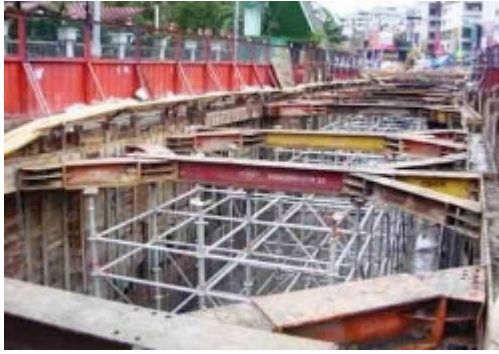
內湖線CB410區段標康寧路三段排水箱涵施工
