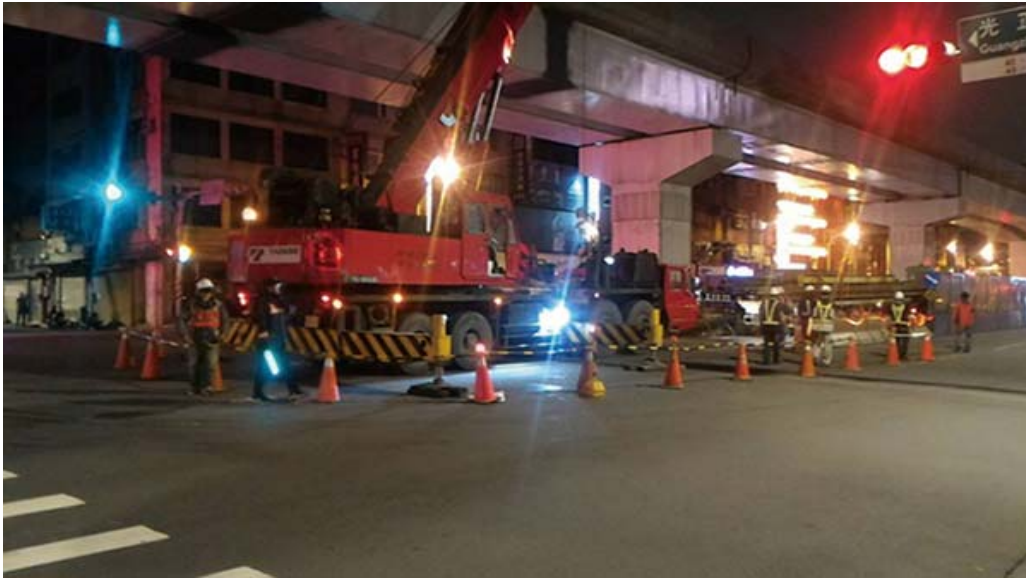
捷運軌道工程施工利用夜間吊掛施工材料至高架橋上
