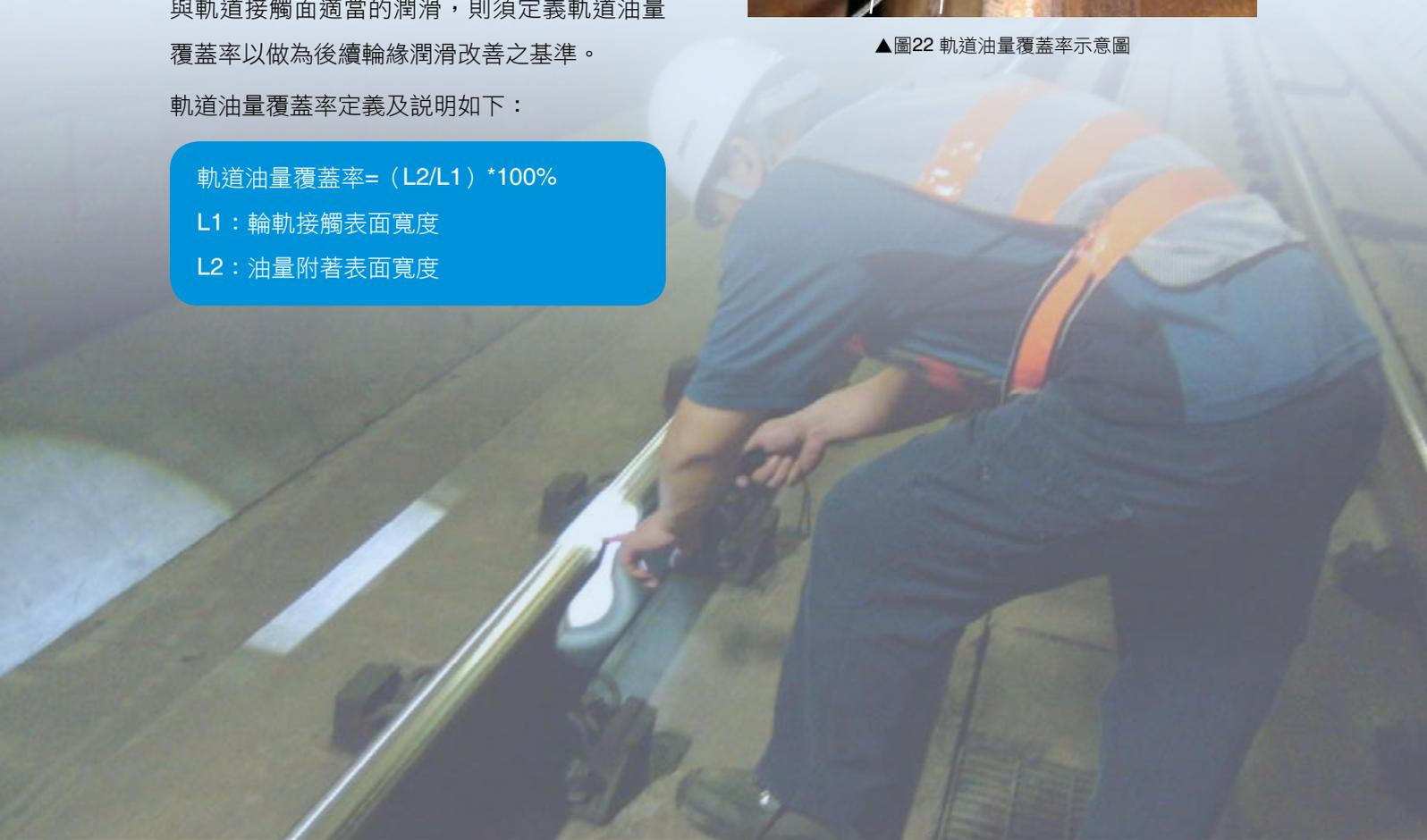
依長期輪緣潤滑改善之經驗得知，輪緣潤滑器於入彎前作動而噴油時，軌道油量覆蓋率與軌道潤滑長度為正比關聯，以曲率半徑200－299公尺為例說明，經觀察後發現當軌道油量覆蓋率為低於25%時，其輪緣潤滑油無法覆蓋全部彎道長度（約200公尺），而導致潤滑不足（車輪異常磨耗且噪音值偏高），如表7及圖23所示，當軌道油量覆蓋率超過一定標準時，輪緣潤滑油覆蓋將超出彎道長度而將油漬覆蓋至直線段（有越位之虞），經長期統計追蹤觀察板南土城暨小南門線最高軌道油量覆蓋率為47%（如表8所示），列車運行且無發生越位情形，故曲率半徑200－299公尺軌道油量覆蓋率標準為比率25%－47%。依上述同理可證，在不同曲率半徑可分析出不同軌道油量覆蓋率標準，如表9所示。
