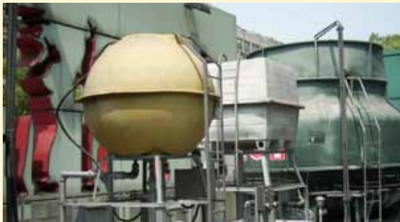
▲圖8 補給水箱及膨脹水箱
