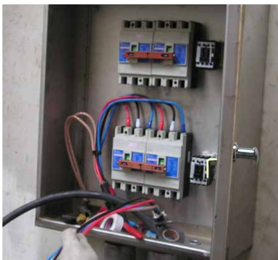
▲圖25 冷卻水塔之隔離開關安裝情形
