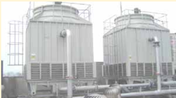
▲圖6 冷卻水塔
