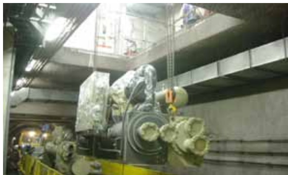
▲圖19 冰水機經由軌道上方吊裝口進場
