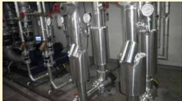
▲圖7 輔助冰水泵及輔助冷卻水泵
