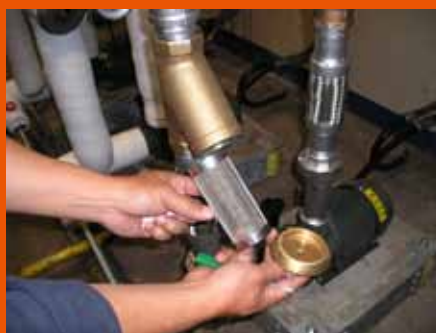
▲圖26 冷卻水循環系統之Y型過濾器安裝情形
