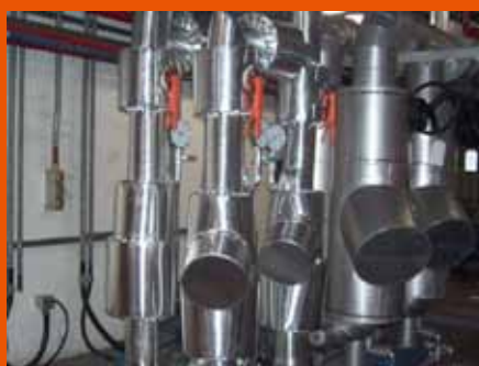
▲圖27 冰水管路完成保溫的情形
