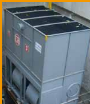
▲圖12 逆流式單側進風冷卻水塔外觀
