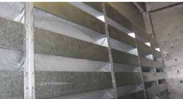
▲圖31 冷卻水塔機房區加裝消音設施
