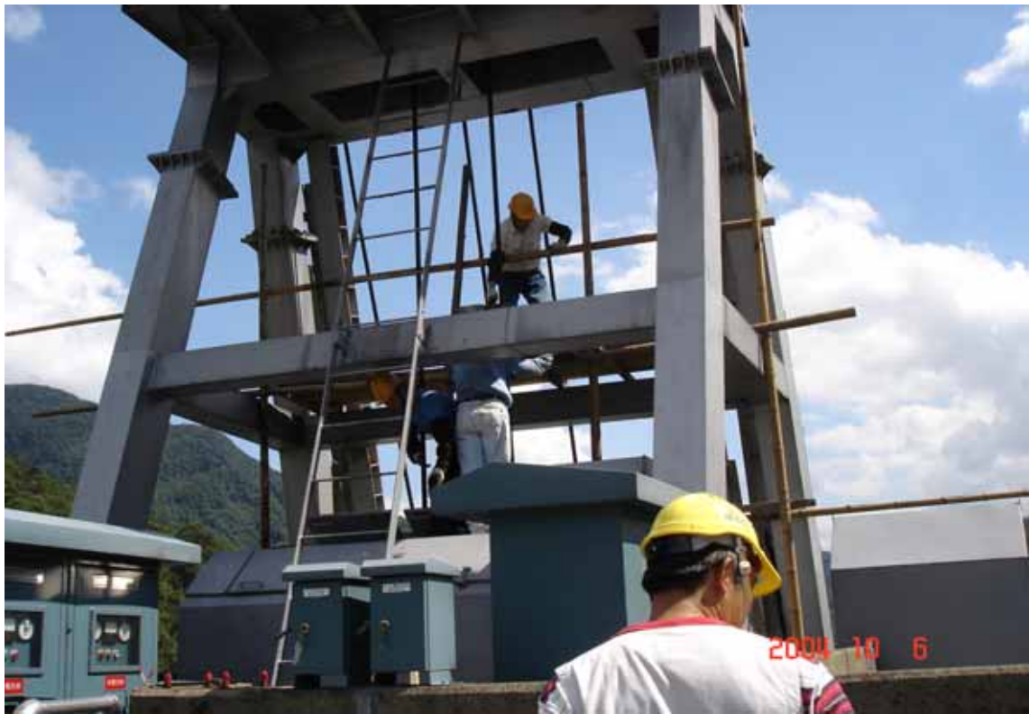
大壩 1 號沖刷道擋水閘門檢修
