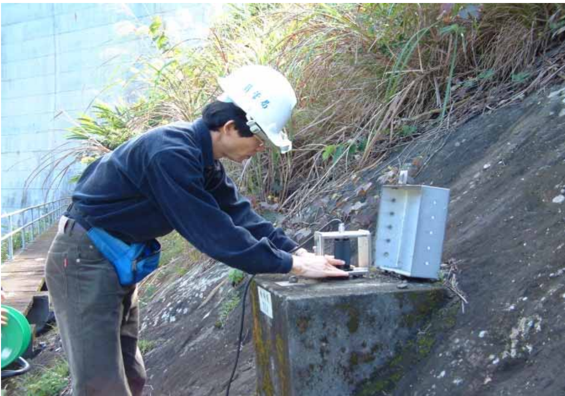
壩座坡面傾斜變位量測
