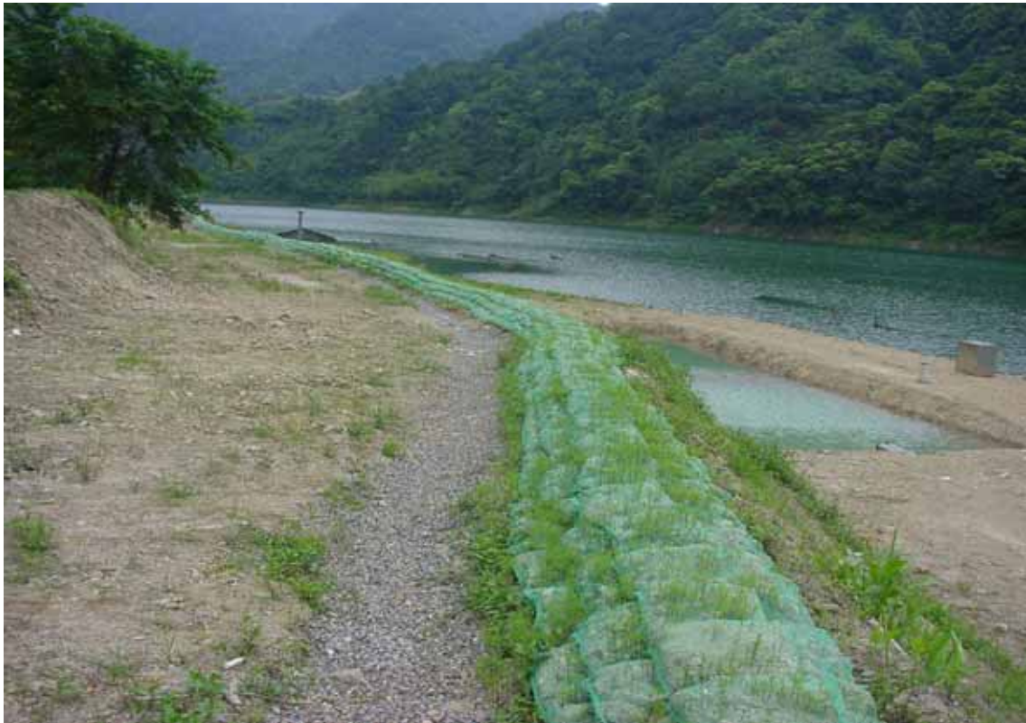
翡翠水庫集水區生態整治計畫-最佳管理作業示範區工程
