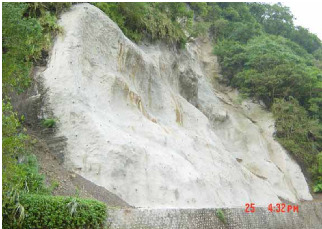
水土保持工程噴凝土竣工
