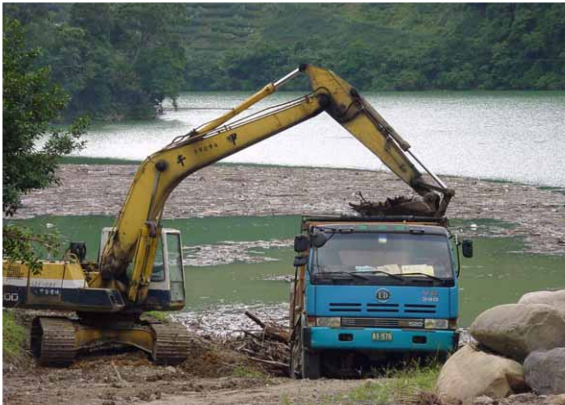
水庫漂流物緊急清除施工
