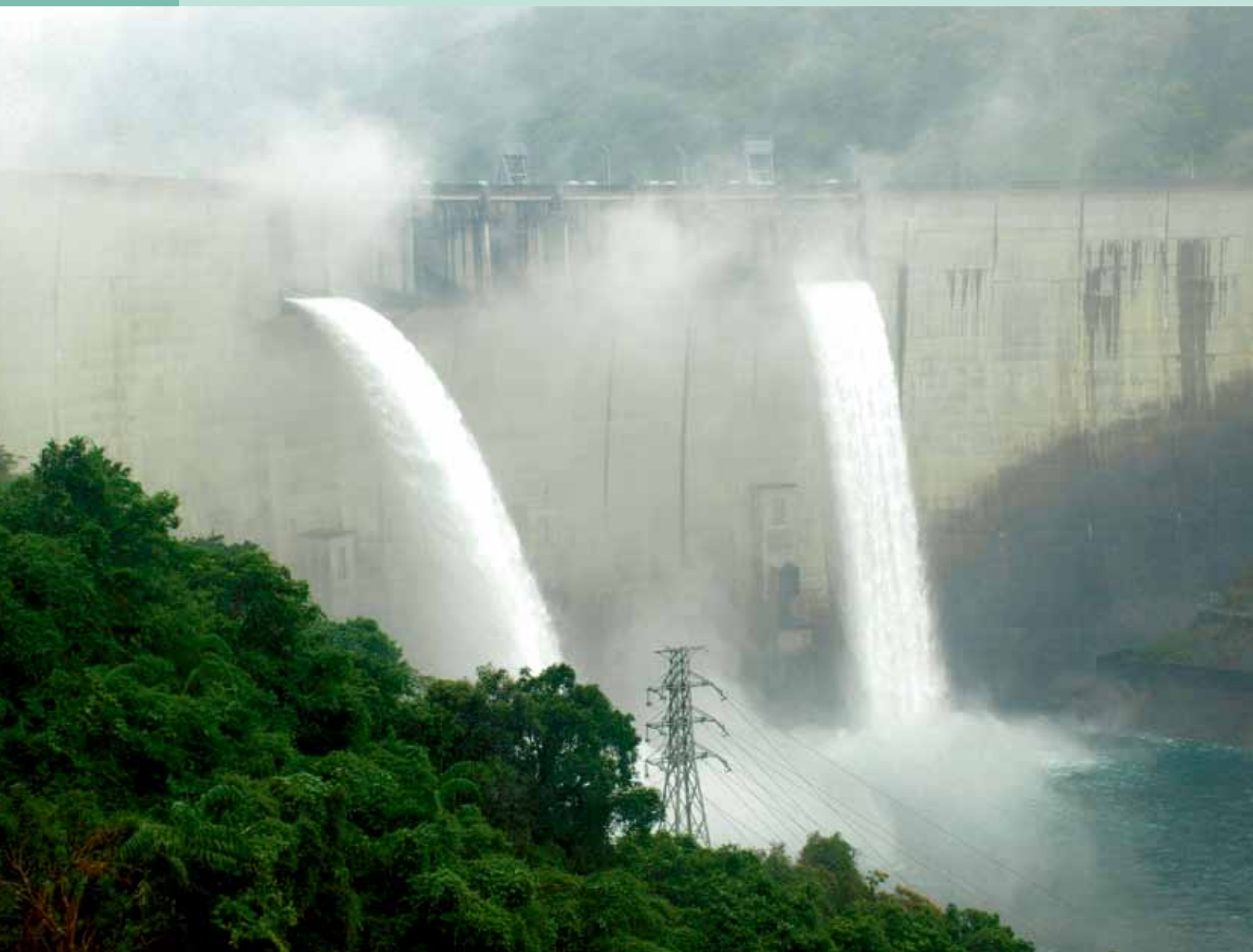
◎溢洪道弧型閘門有水試操作
