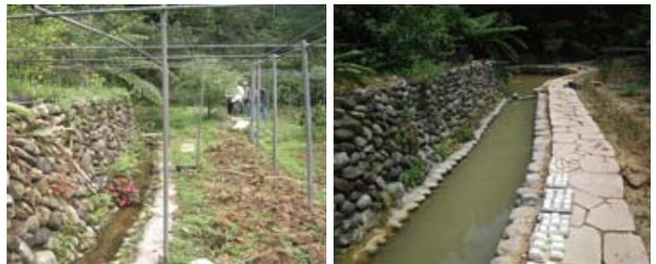
▲內湖某農地申請農地水土保持輔導(左圖)，經水土保持服務團指導後，完成駁坎補強、水溝拓寬，並於末端增設水塘(右圖)，不但坡地安全獲得保障，景觀也美化了
