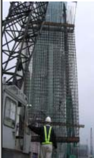
圖 8：現場施作連續壁及玻璃纖維強化補強筋 GFRP 示意圖
