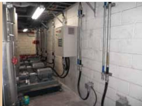
圖7 變頻控制盤安裝位置
