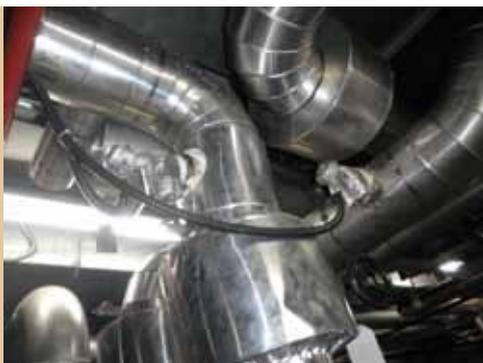
圖6 冰水溫度感知器安裝位置
