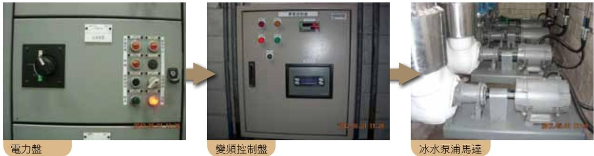
圖2 變頻冰水泵馬達用電設置流程圖
