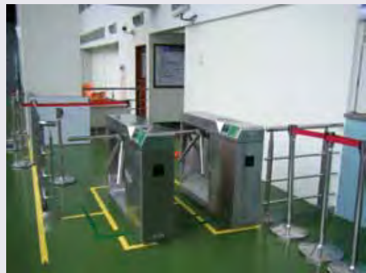
圖16 安裝完成之進站閘門
