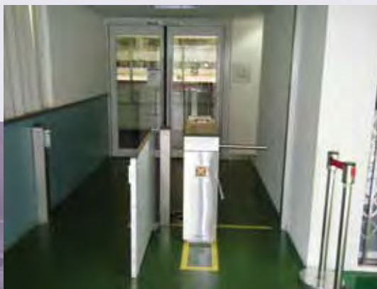
圖17 安裝完成之出站閘門
