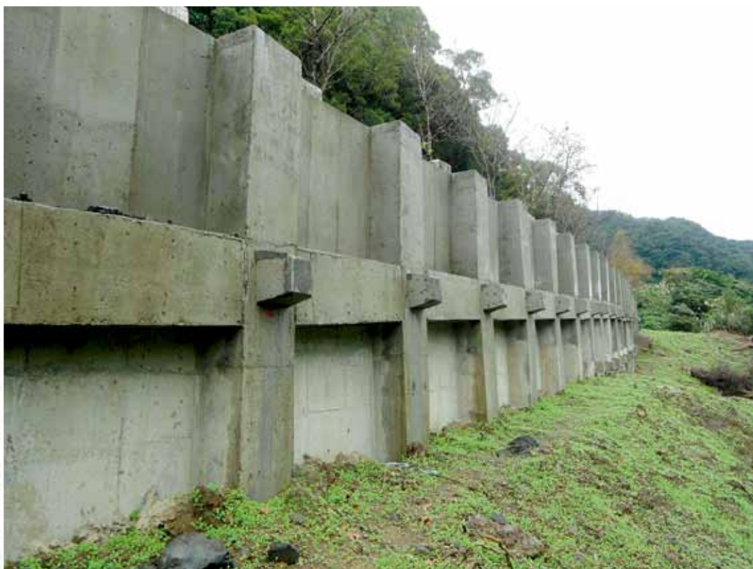
▲一號短橋旁下邊坡預力地錨施作
