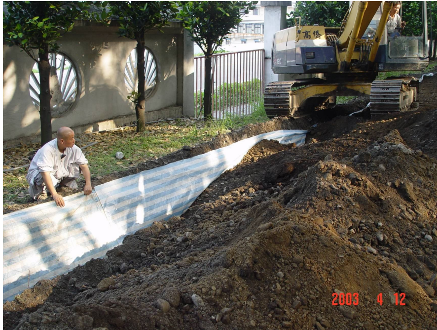
圖一：利用不透氣的塑膠布建立阻絕溝來區分燻蒸範圍。
