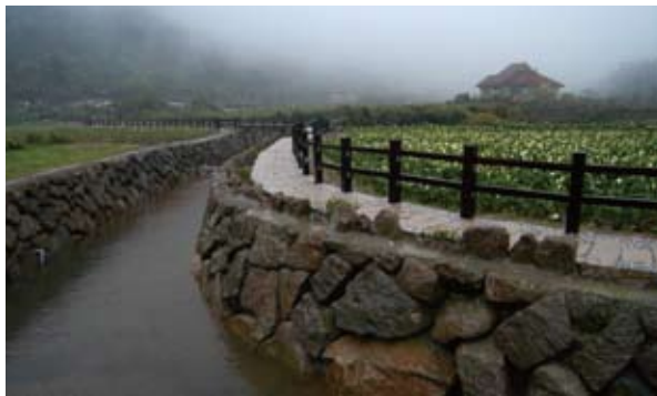
↑河堤護岸以塊石疊砌，不使用水泥，保留縫隙供花草滋長，飛蝶鳥蟲得以穿梭棲息。
