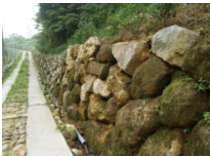
↑邊坡以當地安山塊石疊砌而成，與景觀調性一致，植物小蟲得以滋長共生，維持基本的生物鏈。
