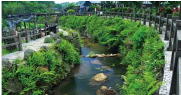
↑整治後的溪溝護岸，石縫間蕨類植物生命力旺盛，綠意盎然。（陳志慎/攝）
