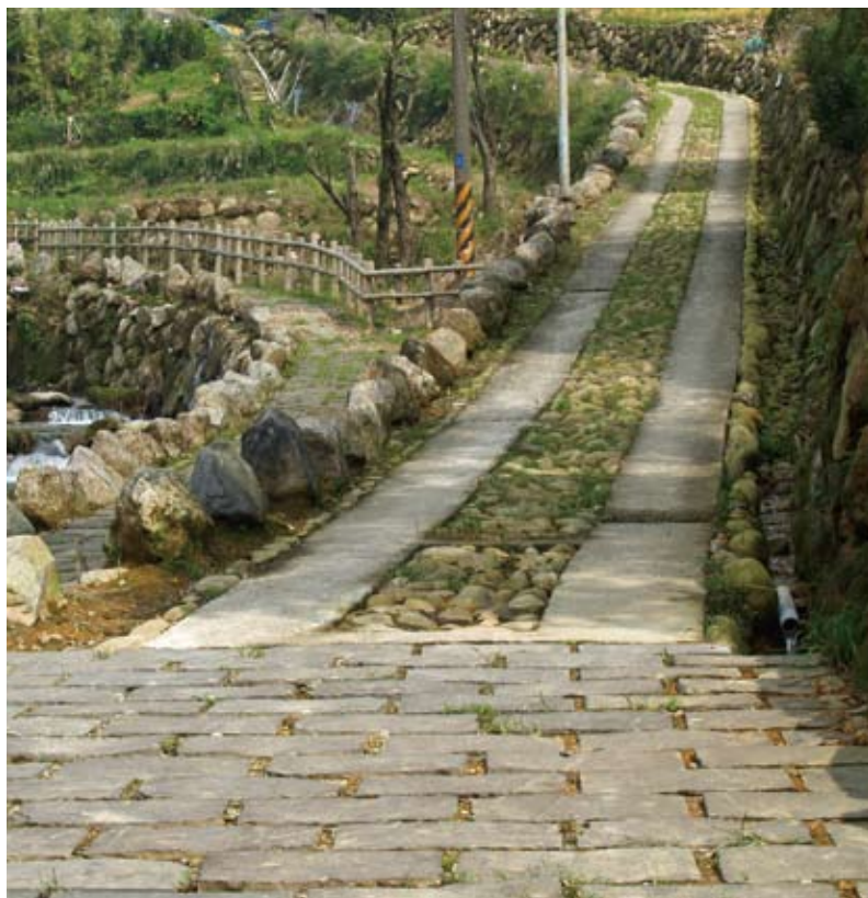
↑沿溪步道工程也不能馬虎，為達到環保與生態要求，與兩側土地互通氣息，避免用水泥灌漿。
