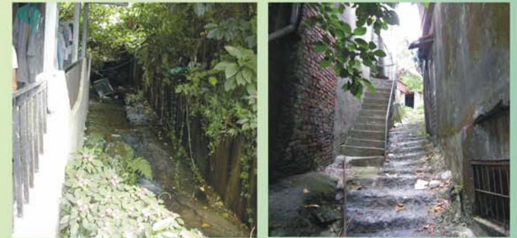
▲ 占用行水區 房屋緊鄰山溝使得河道斷面 束縮，暴雨時易造成溪水溢 流，造成下游土砂災害
