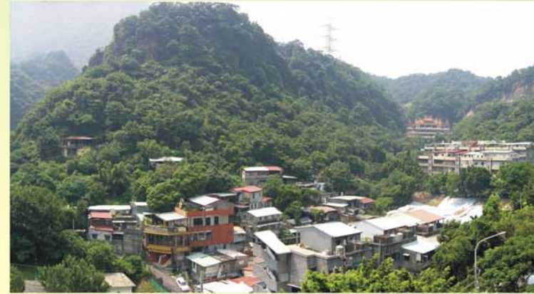
第二期拆除前全景
