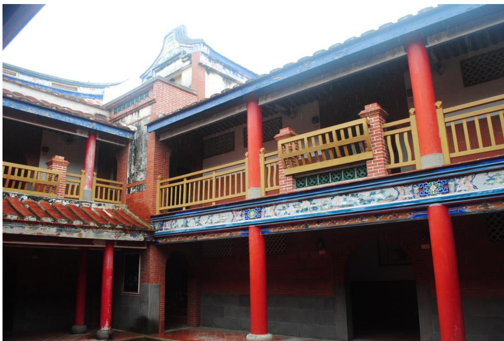
南鯤鯓代天府古色古香的建築
