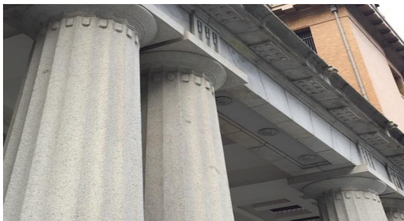
圖 五-51：現代耐震材作補強
