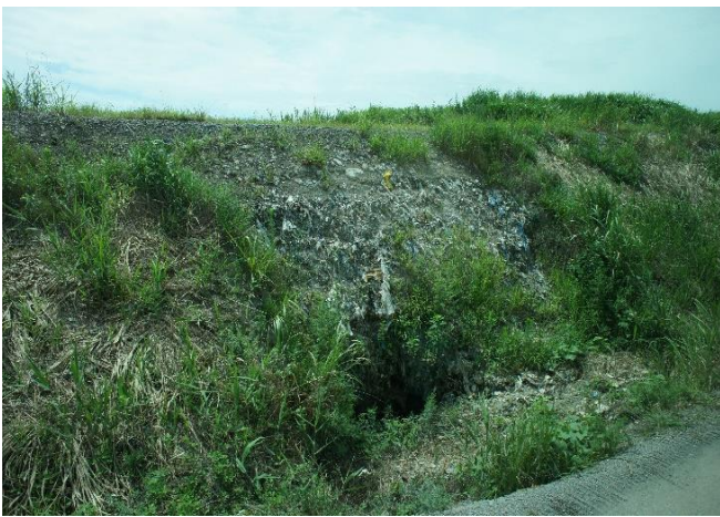
圖 三-28：垃圾採三明治式工法掩埋情形
