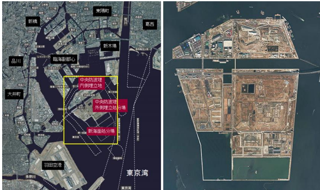
圖 三-26：東京都廢棄物掩埋處理場
