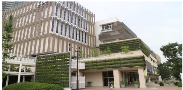
圖 三-8：柏之葉地區辦公大樓垂直綠化及牆面太陽能板裝設情形
