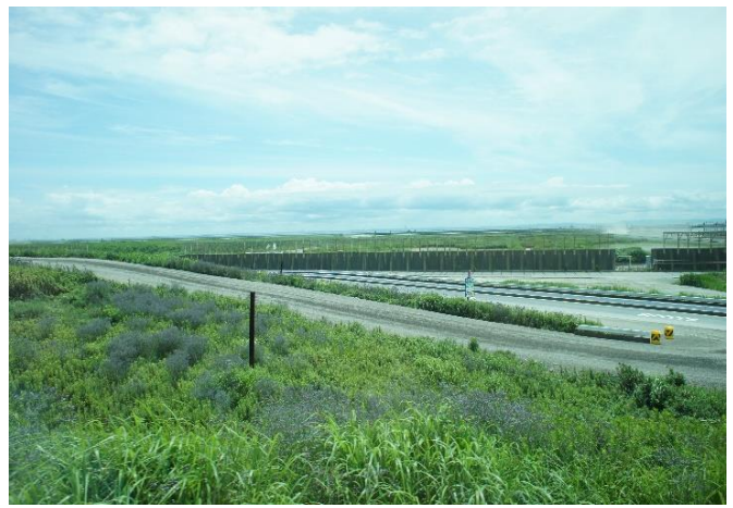
圖 三-29：掩埋場沼氣排氣管設置情形
