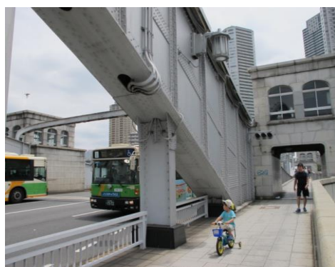
圖 五-47：石塔建造物設有機械控制設備
