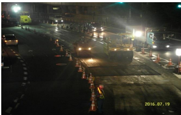
圖 四-5：日本道路夜間施工情形
