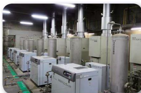
气体的有效利用设施（微型燃气轮机）
