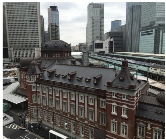
圖 五-41：車站後方地面層多條鐵道
