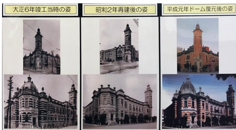
圖 五-20：橫濱市開港紀念會館不同時期修建的面貌
