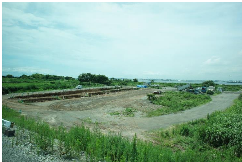
圖 三-30：底(融)渣、飛灰及污泥採分區骨架式掩埋情形
