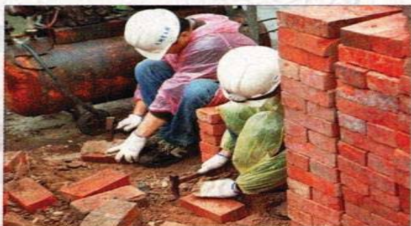
▲工人仔細將磚頭邊水泥敲除，為保存日據紅磚修建日新國小紅樓。（張謙俊攝）
