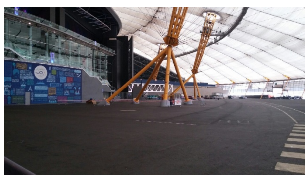
圖 8：支撐 The O2 Arena 的鋼柱（黃色）
