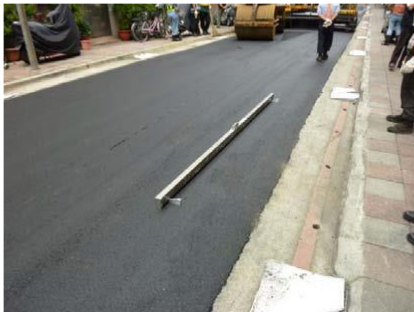
圖 2：確認道路平整度及洩水坡度
