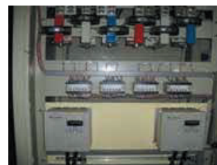
冷卻水塔馬達加裝變頻器
