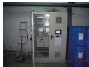
變頻器控制馬達泵浦轉速
