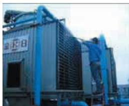
空調系統-冷卻水塔清洗
