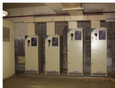
▲ 低壓側裝置進相電容器自動補足功率因數
