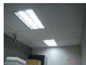
更新為 T5 燈具(PET 反射聚光板)含及電子式安定器並減少燈管數量
