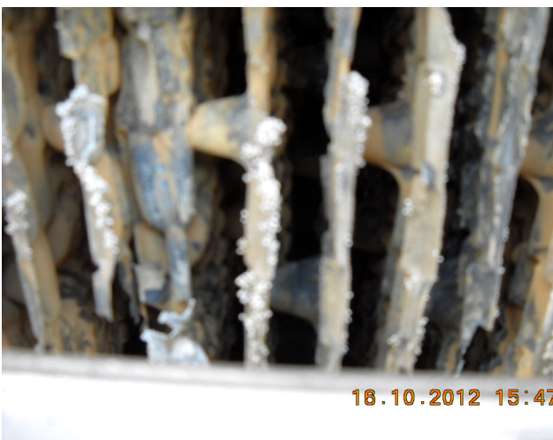
冷卻水塔散熱材現況
