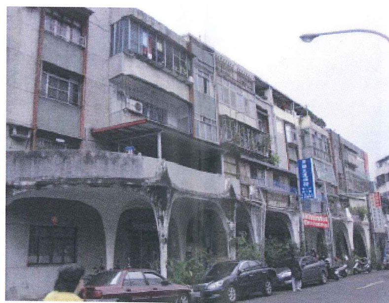
照片 3 懷德街與懷德街 11 巷交叉口
