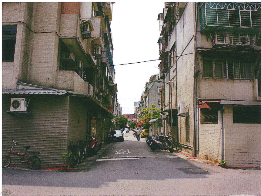
圖 1 東陽街 432 巷現況
