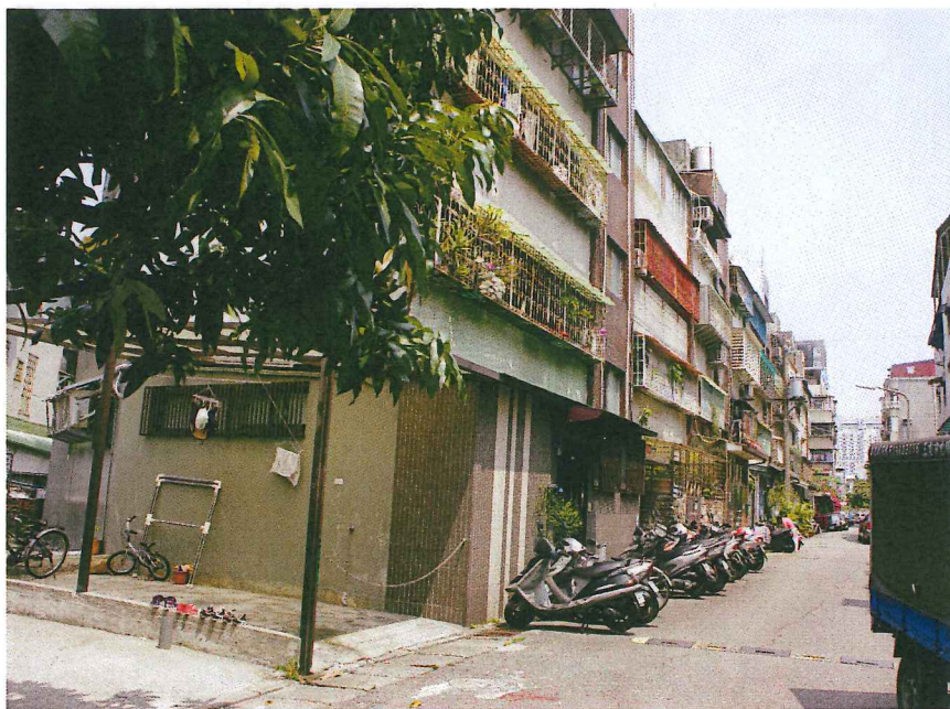
圖 2 懷德街 11 巷建物現況
