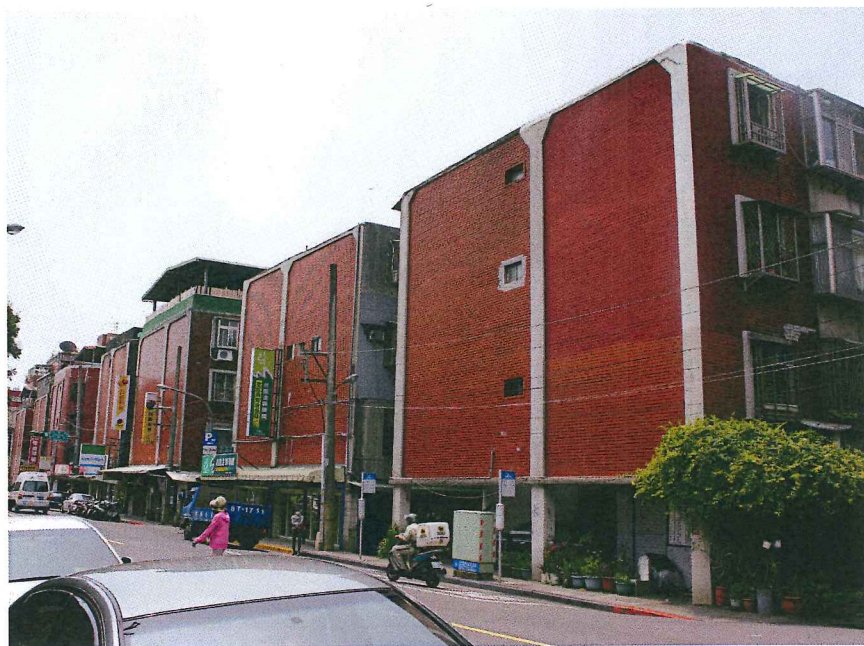
圖 1 明德路建物現況
