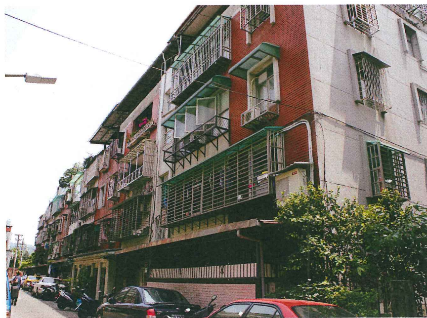
圖 4 明德路 333 巷建物現況
