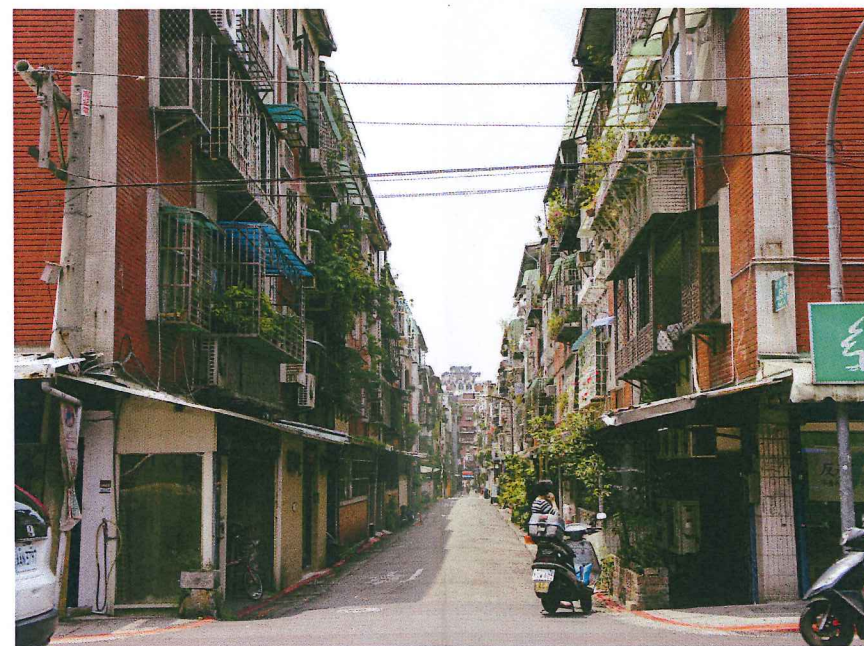
圖 5 明德路 331 巷建物現況
