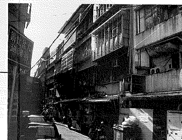
居住環境窳陋 建物老舊社區環境窳陋 建物密集、空地零散 現有巷道狹窄
