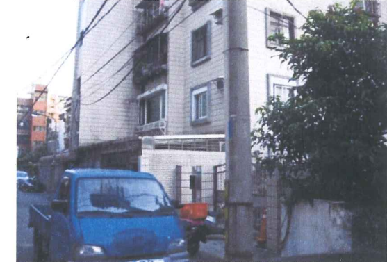
6. 石牌路二段343巷 (西北向東南)
