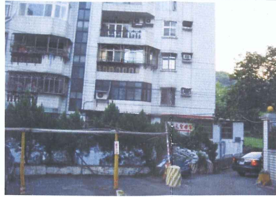
4. 石牌路二段343巷 (東南向西北)
