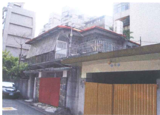
1. 石牌路二段343巷（道路未開闢）
