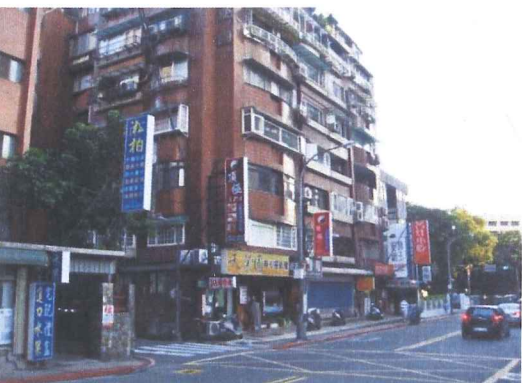
11. 石牌路二段 (東北向西南)
