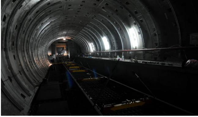
捷運環狀線大坪林站浮動式道床軌道鋪軌
