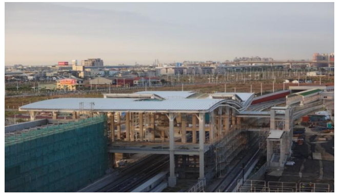
臺中線 CJ910 區段標 G0 車站及軌道施工
