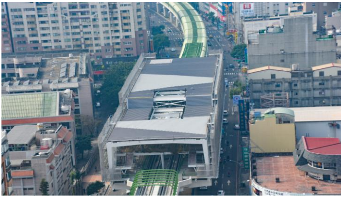
臺中線 CJ920 區段標 G08 車站施工現況
