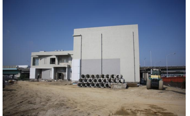
臺中線 CJ930 區段標 BSS 主變電站施工現況
