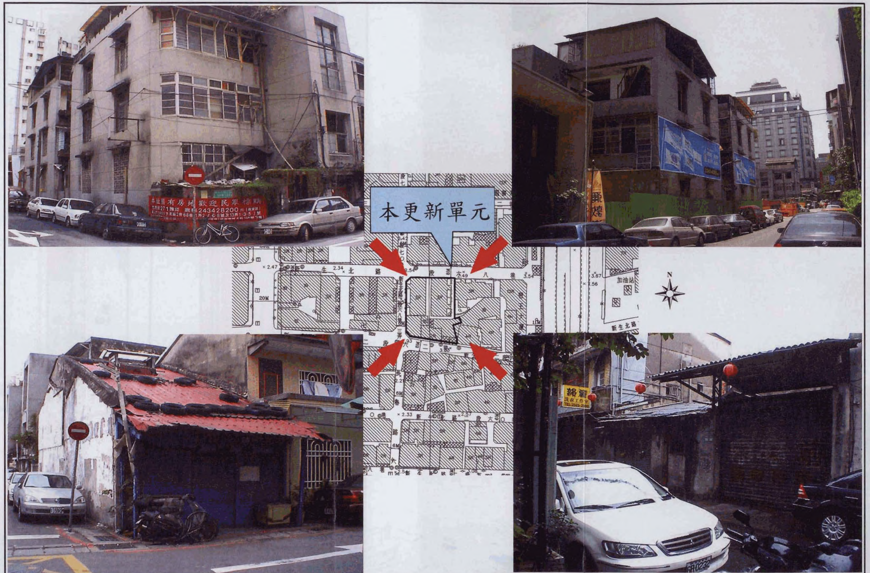
附圖七 更新單元現有房舍現況
