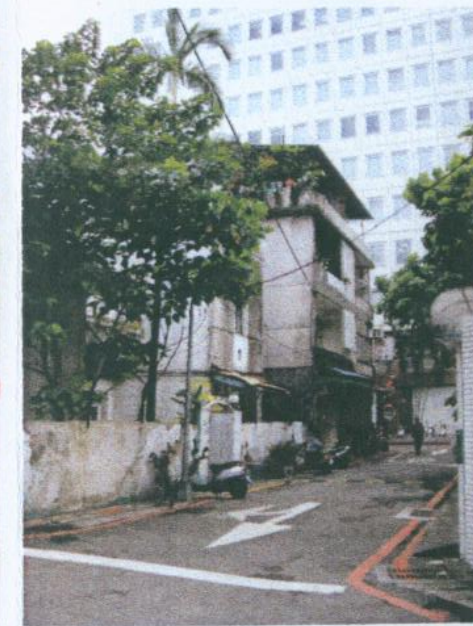
9. 南側 6 公尺巷道現況
