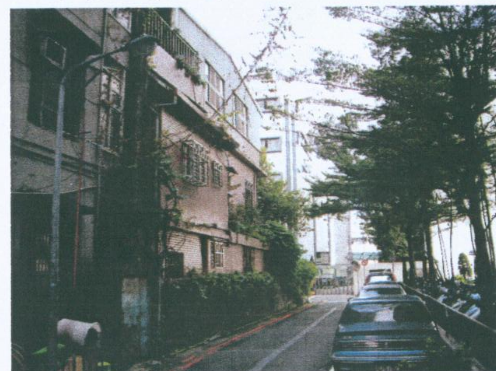
4. 東側 6 公尺巷道現況
