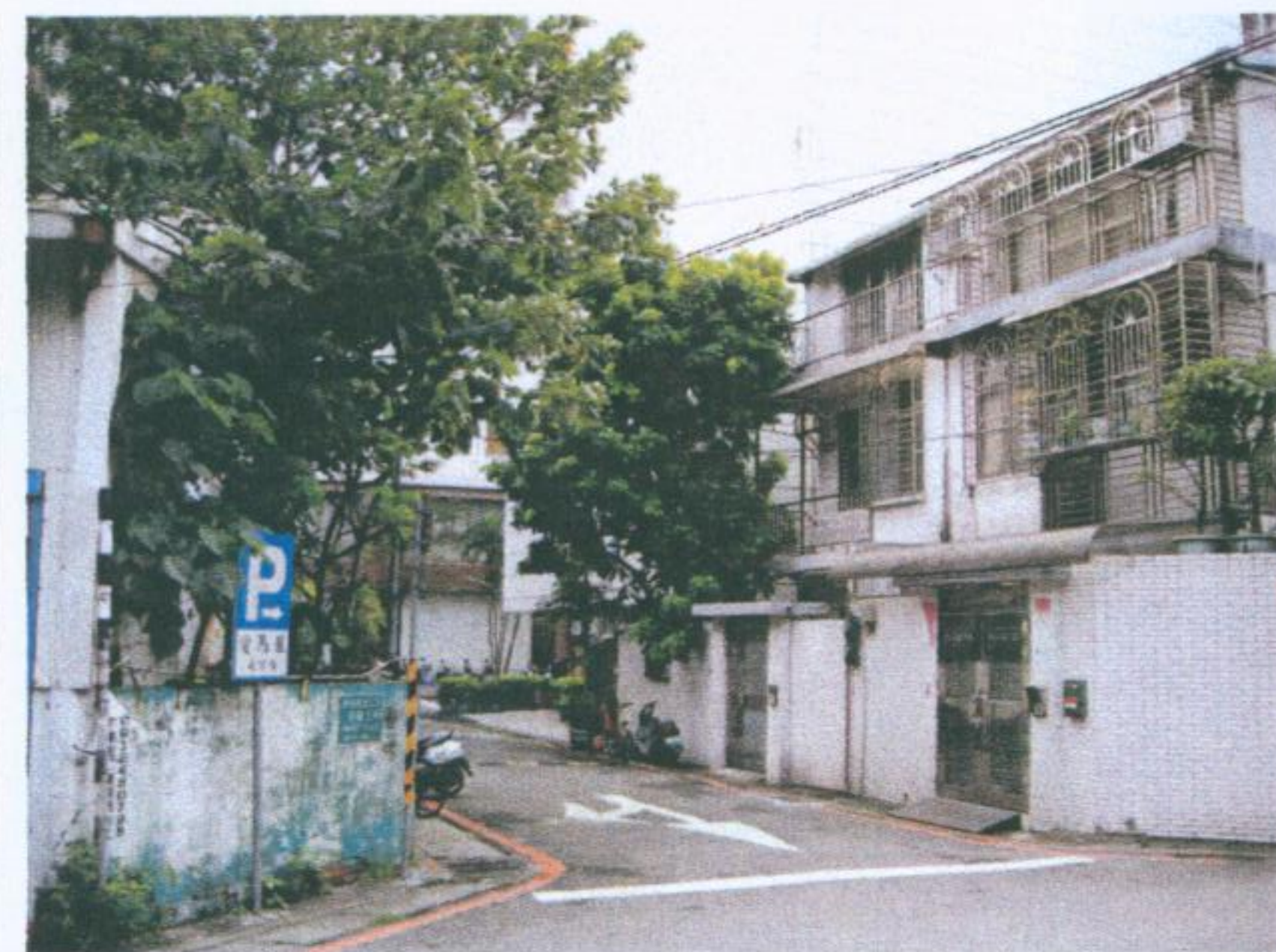
8. 南側 6 公尺巷道現況
