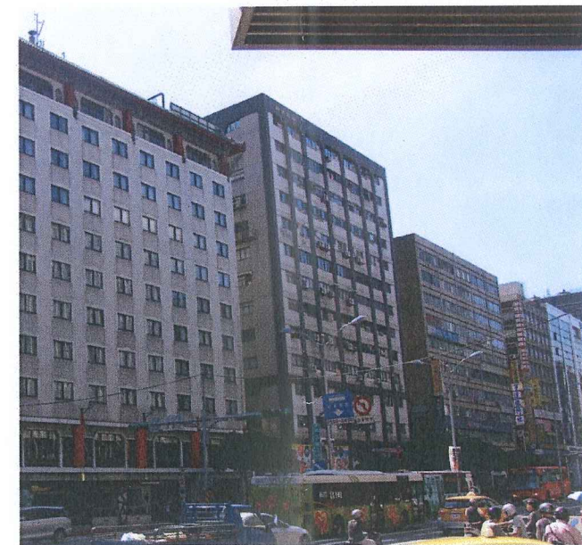
5. 松江路、松江路133巷口
