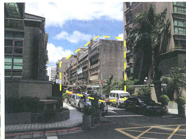
7. 建國北路二段 226 巷建築物現況
