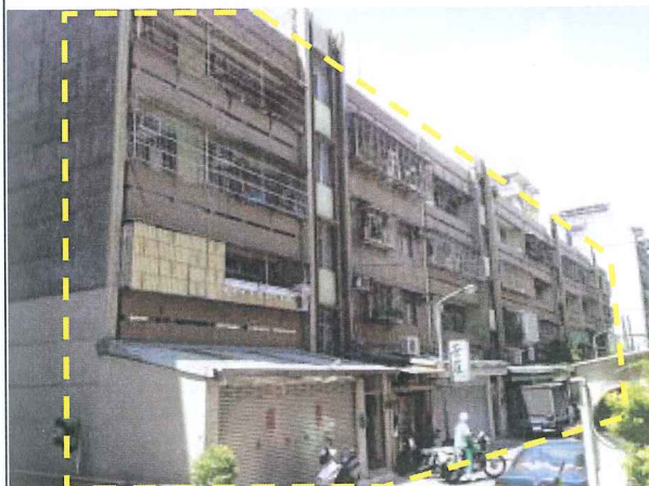
8. 民權東路二段 152 巷 6 弄建築物現況
