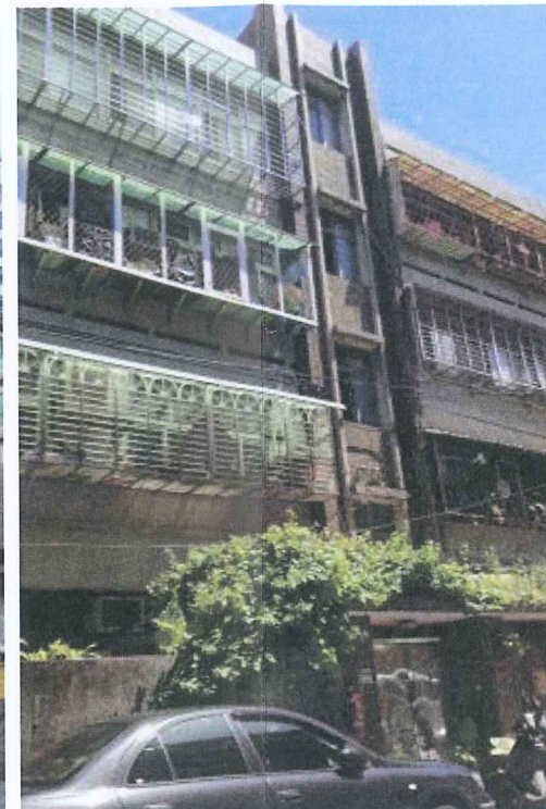
2. 建國北路二段 226 巷 51、53 號 1~4 樓
