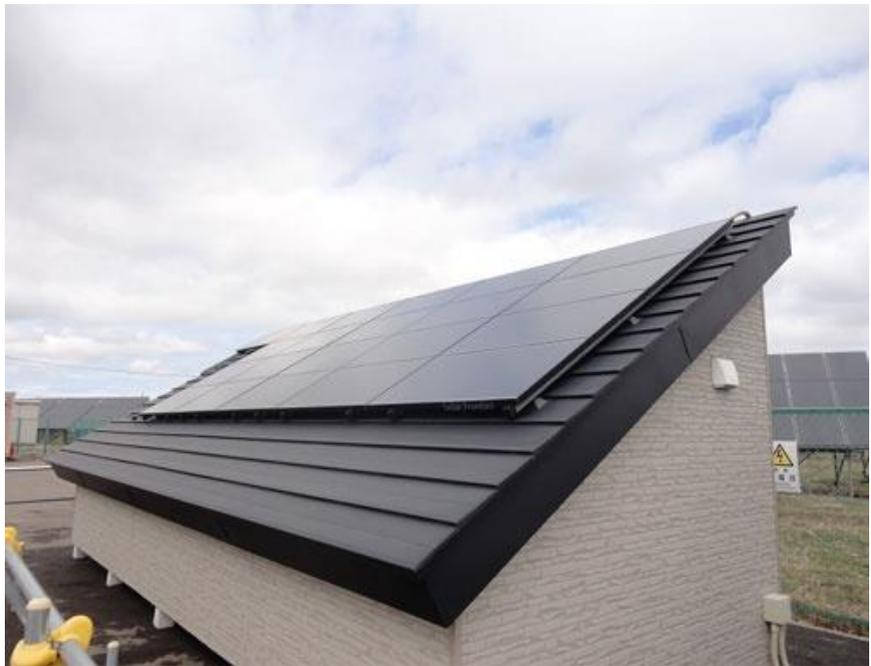
圖 60：坡度為 31 度的落雪屋頂上設置電池板
