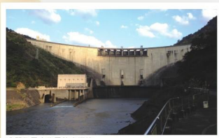
翡翠發電廠發電放水照片
