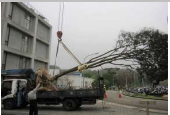
吊掛索具與樹幹之接觸部位應加襯墊包裹保護
