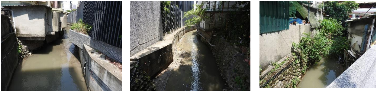
圖 8 慈生宮後方尚存水圳(較寬部分)
