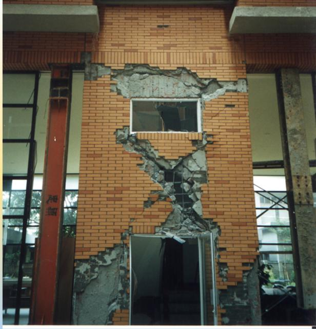
地震造成的剪力裂縫
