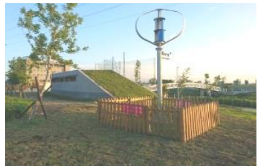
▲公 5 公園風力發電機
