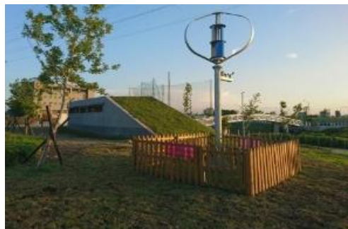
▲公 5 公園風力發電機
