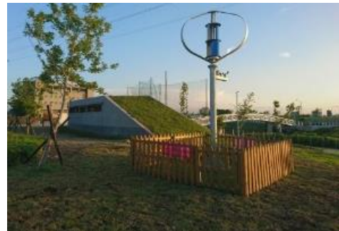
▲公 5 公園風力發電機
