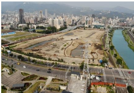
▲ 第2期填土整地工程施工現況
