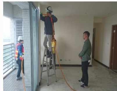
▲ 專案住宅交屋修繕
