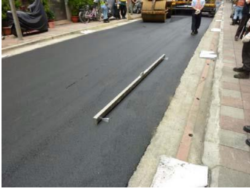
圖 2：確認道路平整度及洩水坡度
