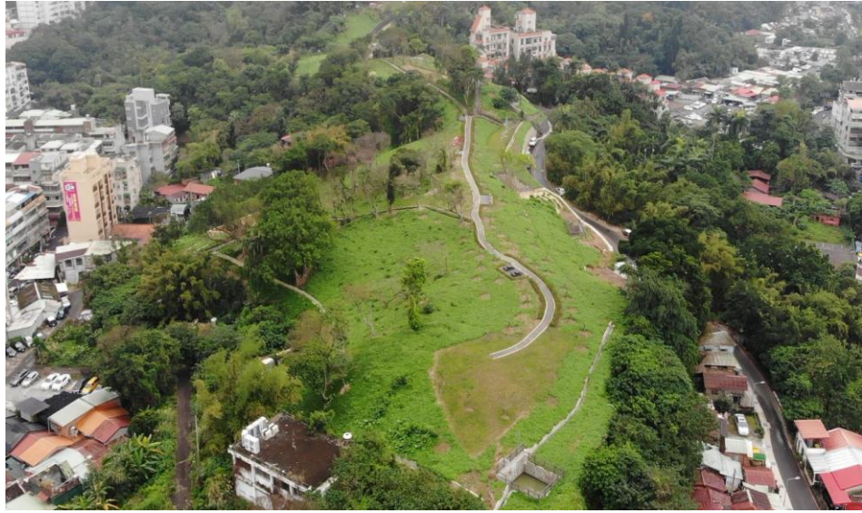
圖 2-3、大安第 6 公墓墓區水保項目完工後相片
