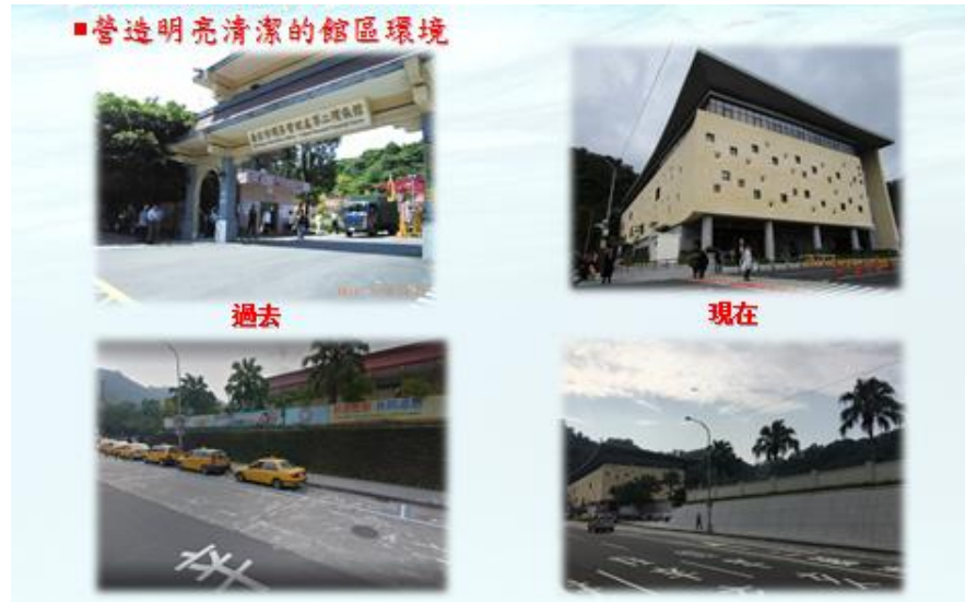
圖 1：二殯一期整建工程前後對照圖
