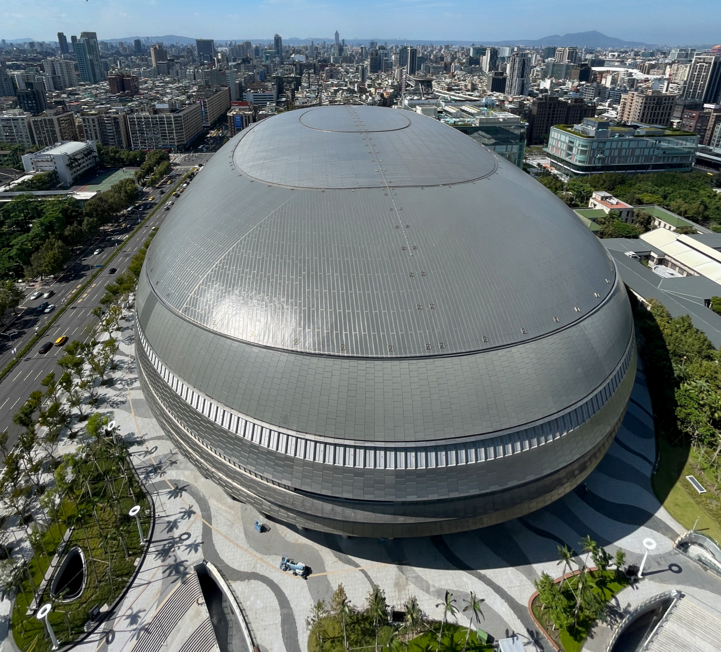
臺北大巨蛋 Taipei Dome
