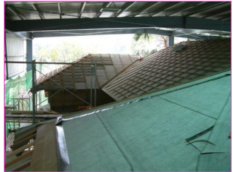
◆薄片鋪貼式防水
