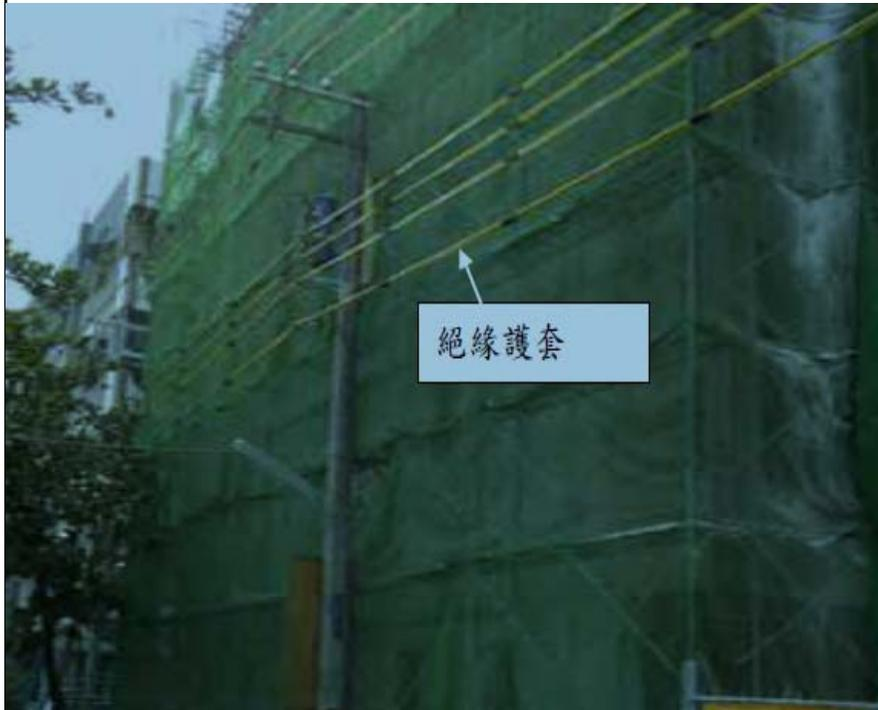
電線架高避免因地面積水導致電線浸水，受外力破壞絕緣而漏電。
