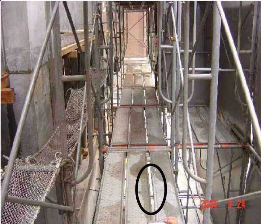
施工架腳部設置基座增加穩定性。
