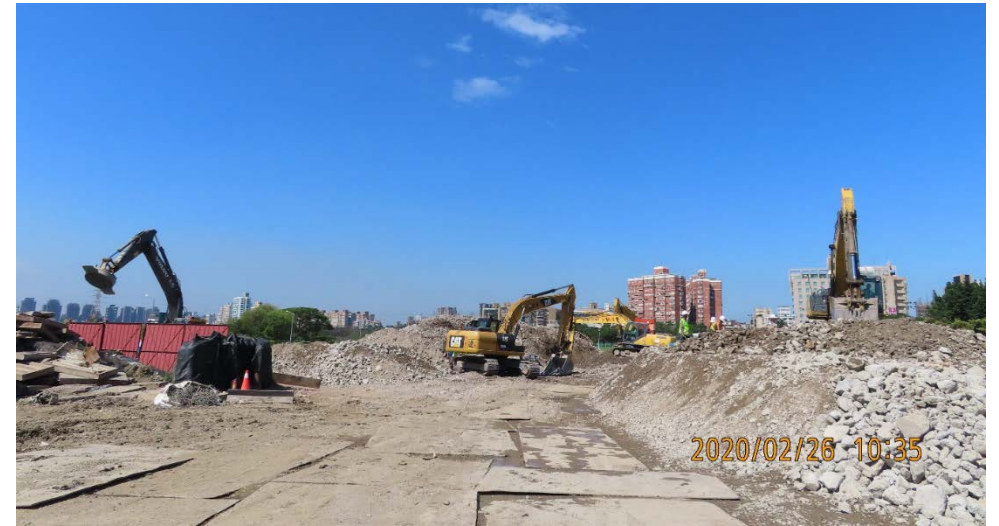
中正橋改建(重慶南路高架橋拆除)
